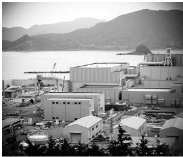
島根県松江市にある日本で唯一、県庁所在地に立地する島根原子力発電所
